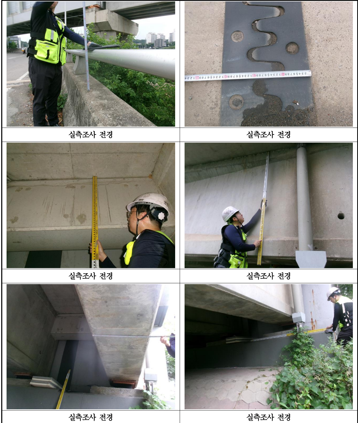
【사진 1.2.1】 교량 전경 및 실측조사 현황
