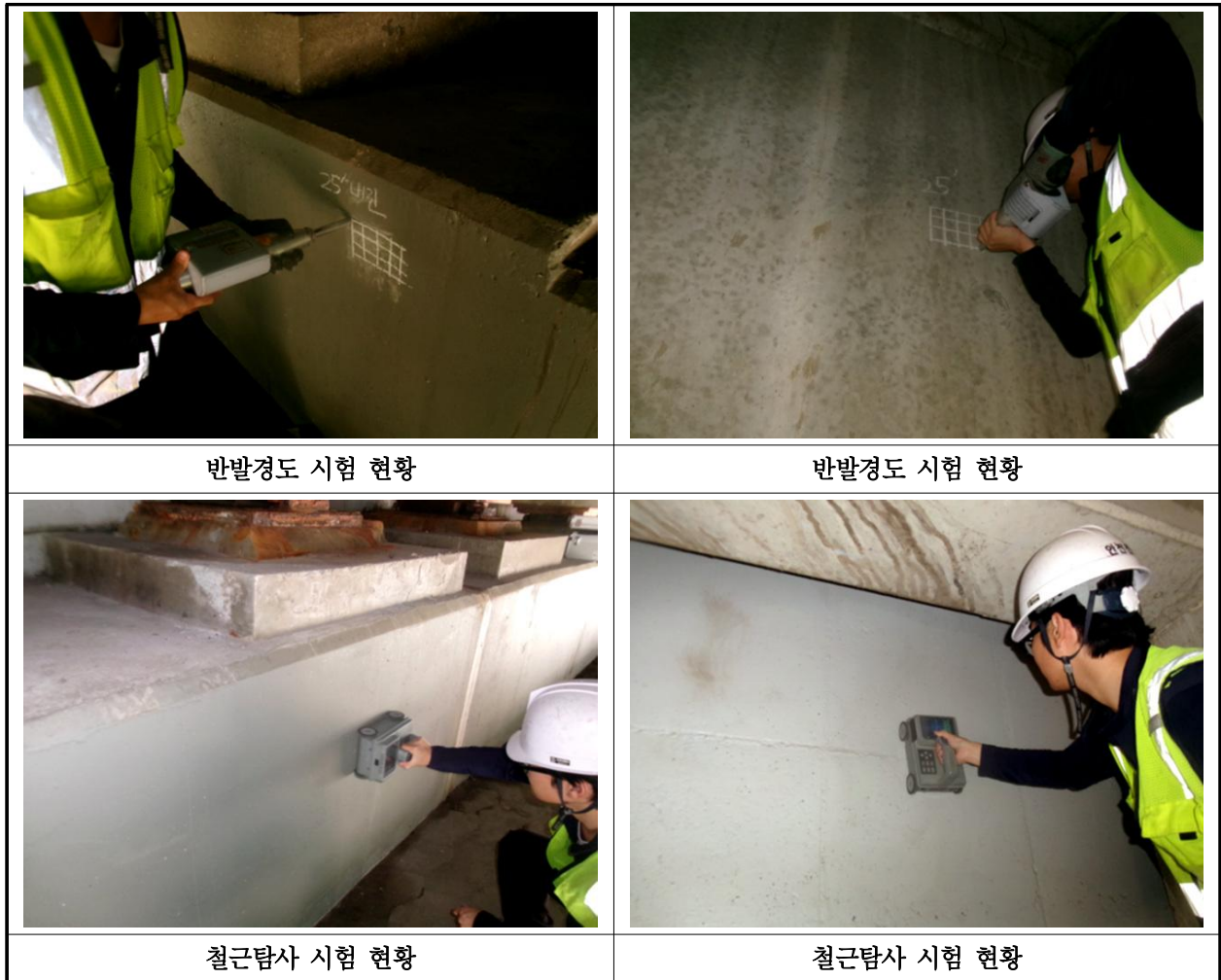
【사진 1.3.1】 콘크리트 내구성조사 현황
