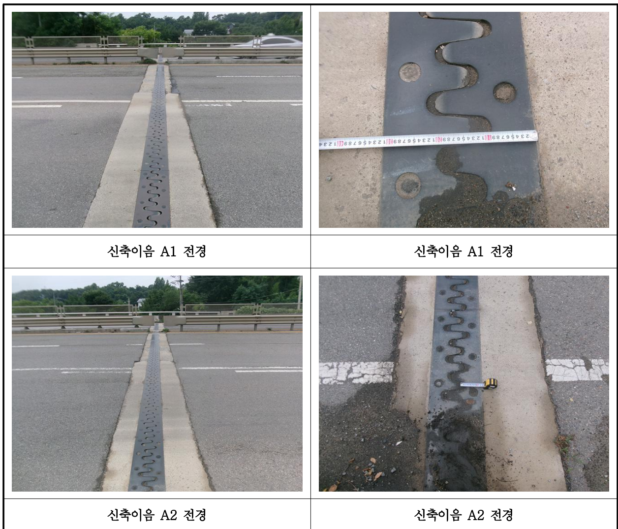
【사진 1.2.3】 신축이음장치 현황
